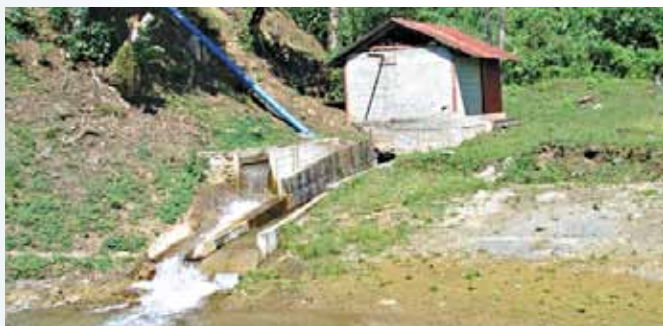
Casa de máquinas de una pequeña centra hidroeléctrica
