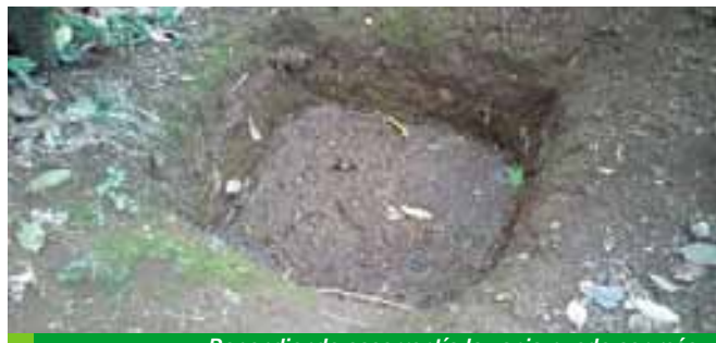
Dependiendo escorrentía la zanja puede ser más grande y debe desazolverse.
