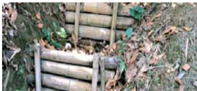
Cuando la cárcava es grande combinar materiales para mejor consistencia y soporte.
