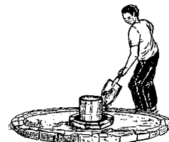
Vierta el concreto para hacer la losa y forme el cuello protector.
