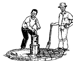
Ponga varillas y un molde para el hueco.
