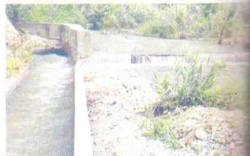
Foto 2: Bocatoma de barraje móvil, MCH Las Juntas
