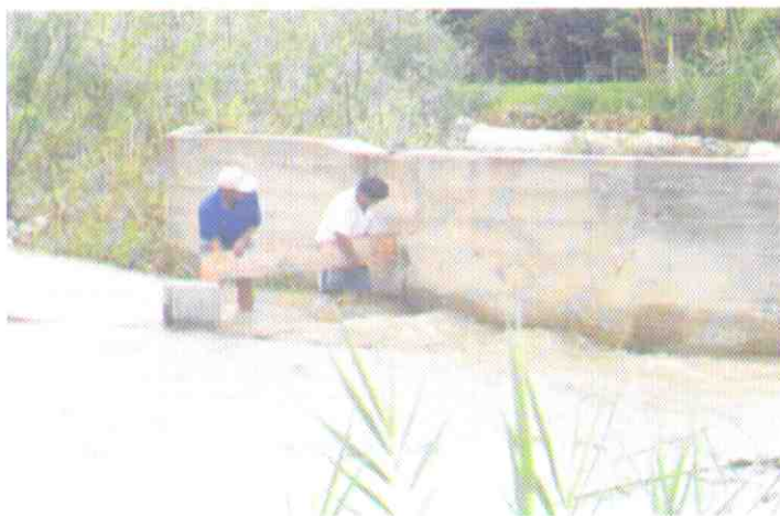
Foto 1: Colocación del barraje en la bocatoma, MCH Las Juntas
