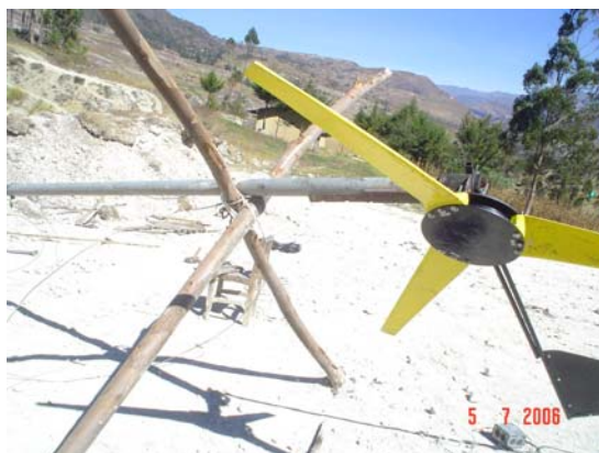
Ilustración 17: Forma de apoyo para ensamblar el aerogenerador
