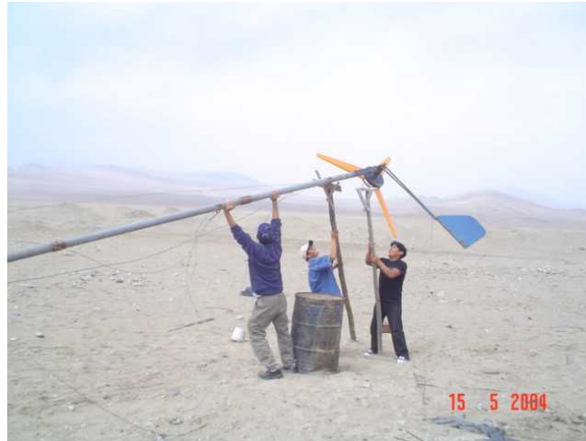
Ilustración 22: Muestra una forma de instalación del aerogenerador
