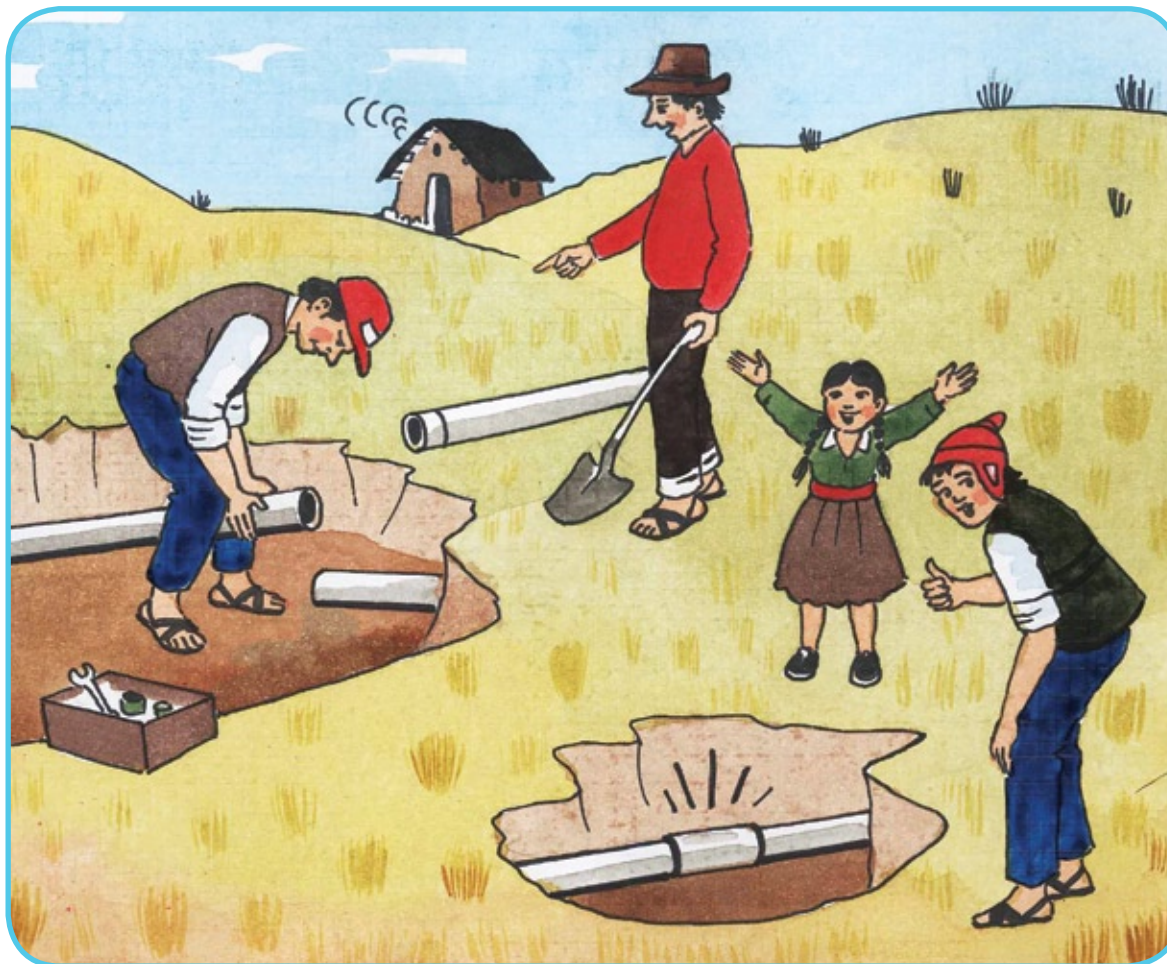
Cambio de tubería rota
