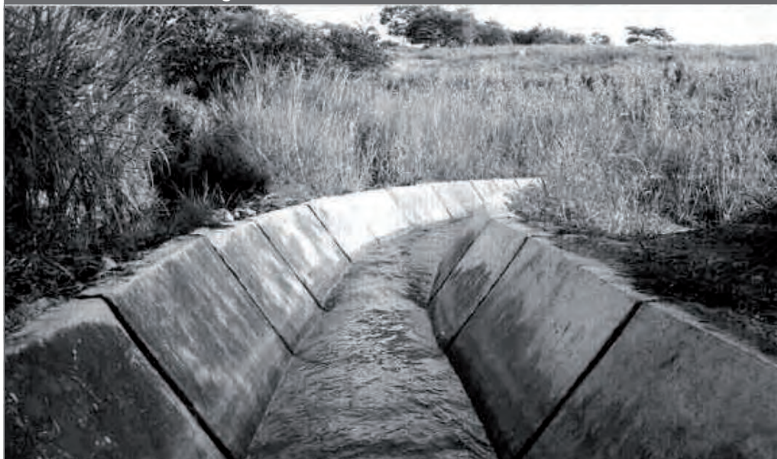
Figura 26. Canal revestido con cerchas
