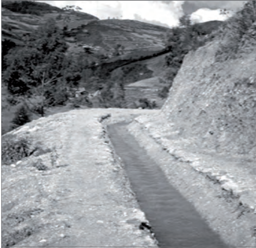
Figura 29. Canal de mampostería de piedra
