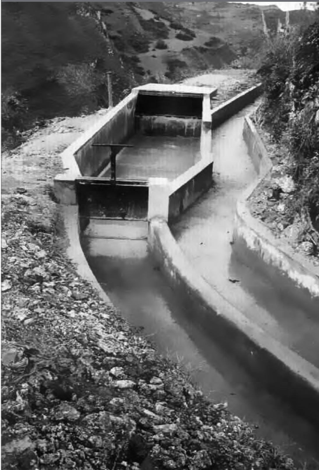
Figura 41. Desarenador a la entrada de la cámara
