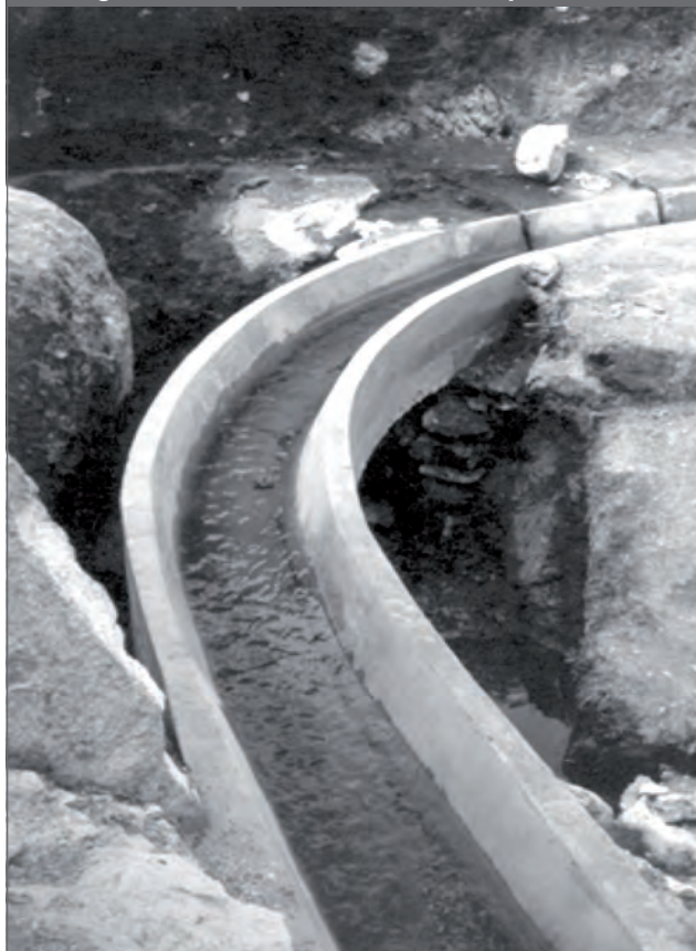
Figura 32. Pase de canal en quebrada
