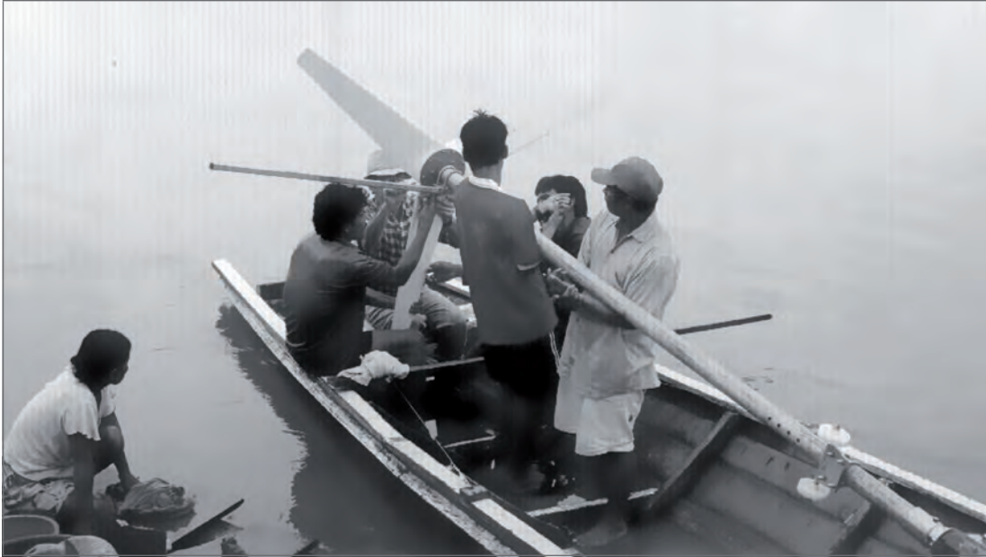
Figura 103. Turbina de río instalada en el río Napo
