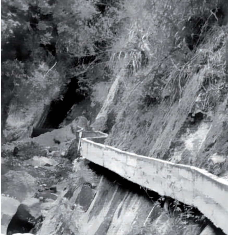
Figura 31. Canal de concreto empotrado en talud
