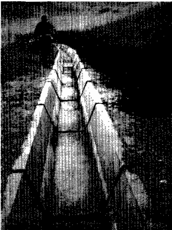
Foto 3.3: Canal trapezoidal revestido.
