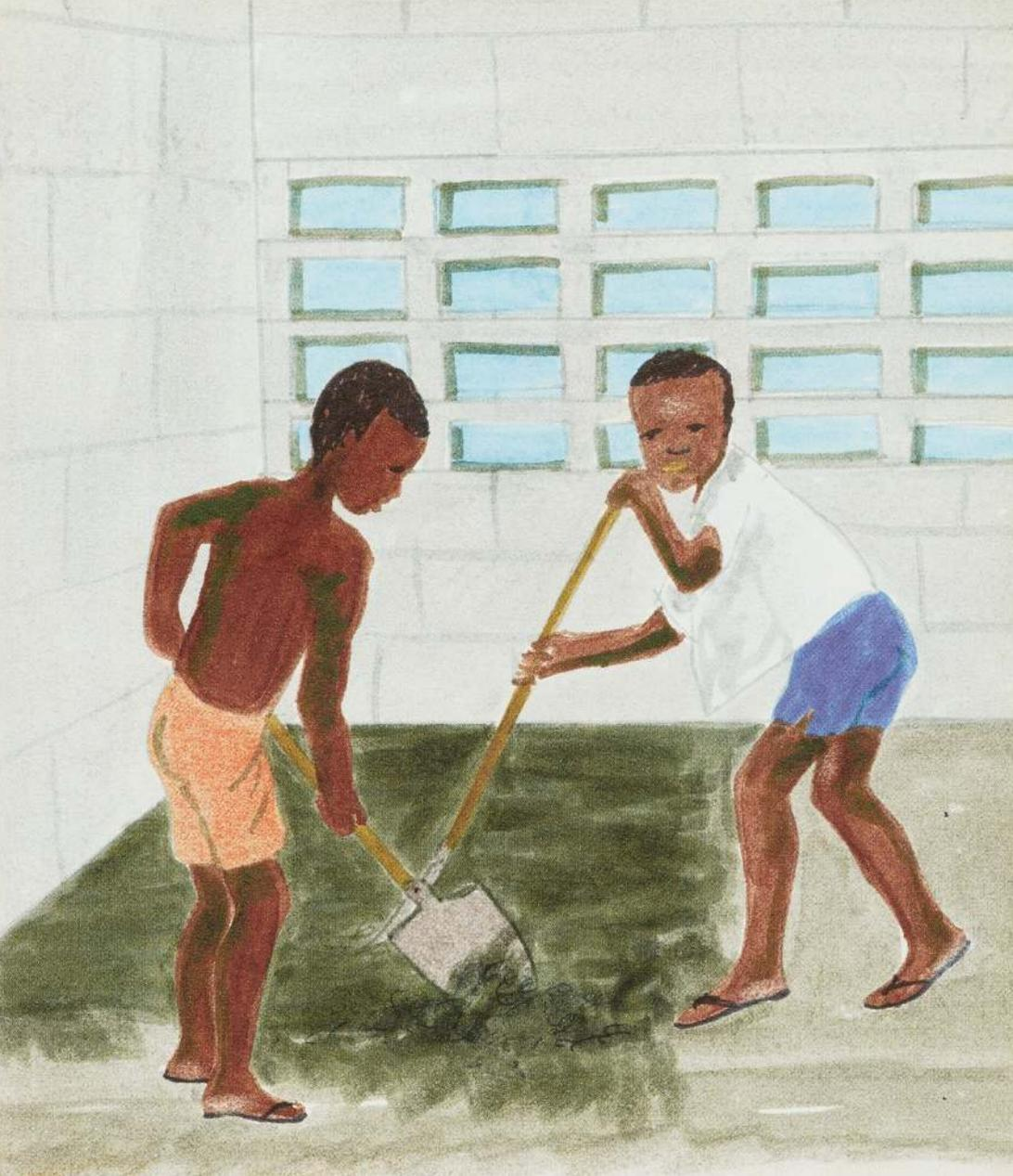
A l'intérieur du bâtiment, les maçons coulent une chape de béton. Pour qu'elle soit bien plane, ils la lissent soigneusement.
