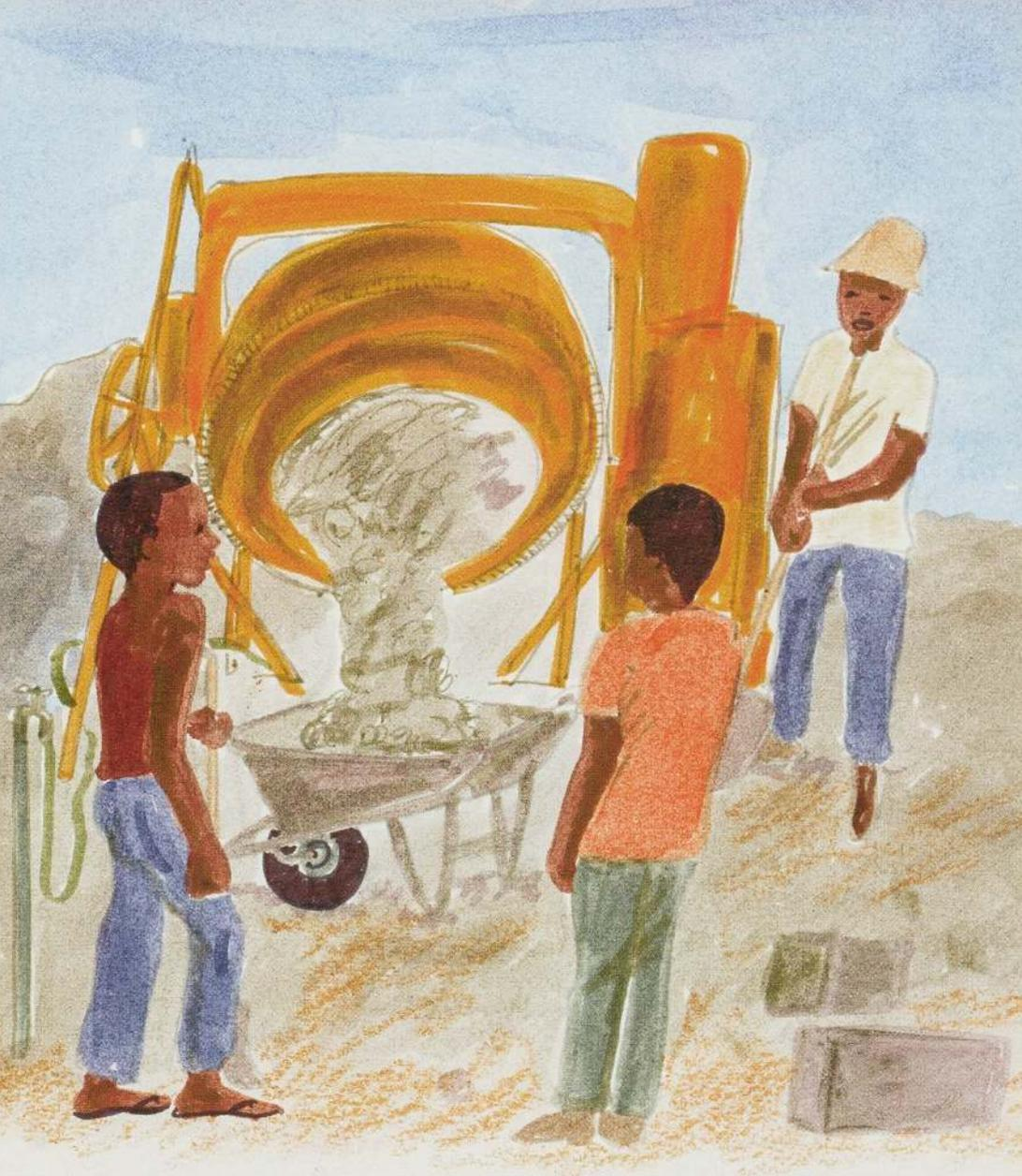
Le béton, bien mélangé dans une bétonnière, est versé dans une brouette, puis il est coulé dans la tranchée.
