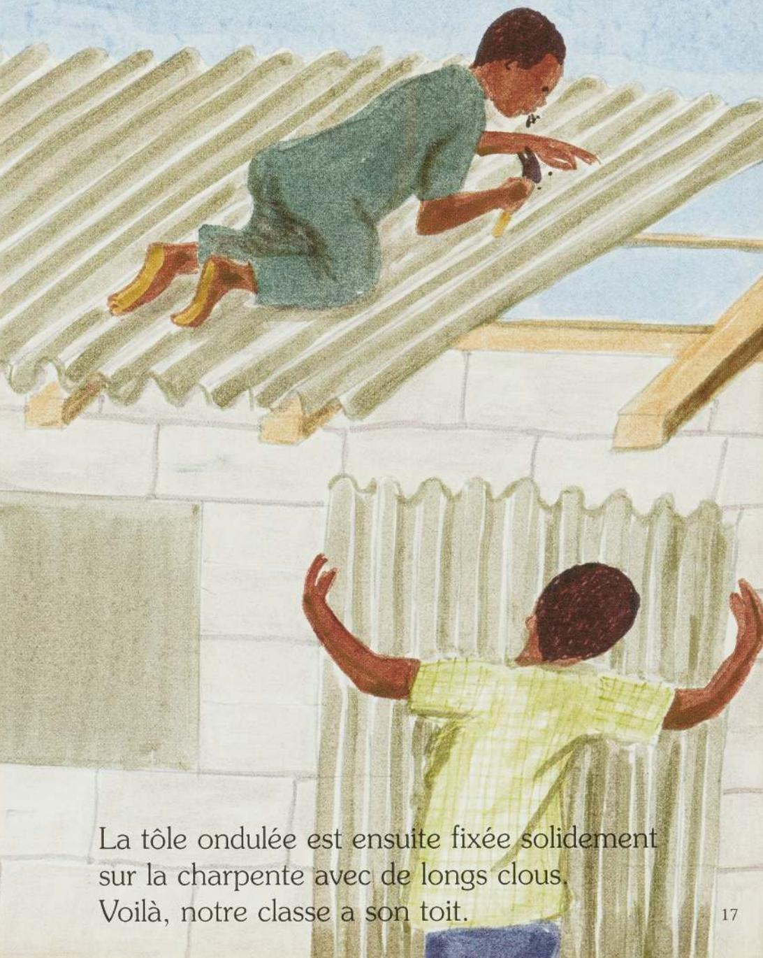
La tôle ondulée est ensuite fixée solidement sur la charpente avec de longs clous. Voilà, notre classe a son toit.
