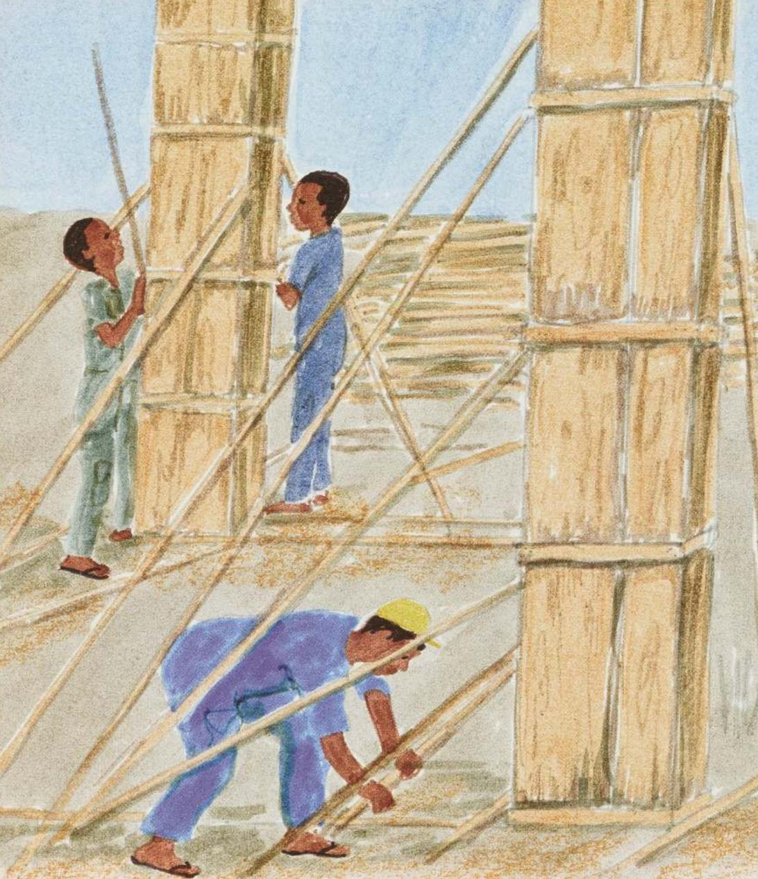
Les ouvriers construisent maintenant des coffrages de bois, et coulent à l'intérieur les piliers de béton. Le chantier est en pleine activité.
